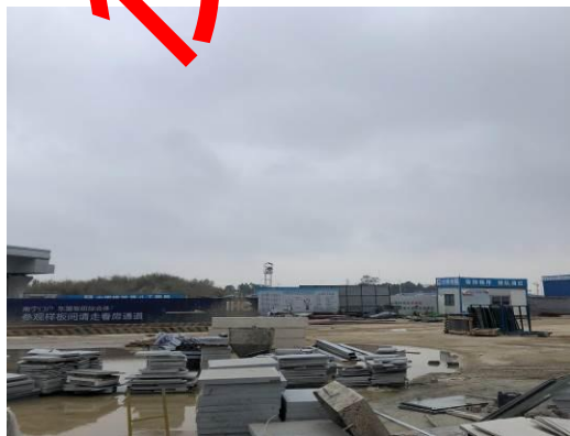
项目东面现状
