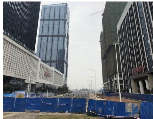
项目南面现状
